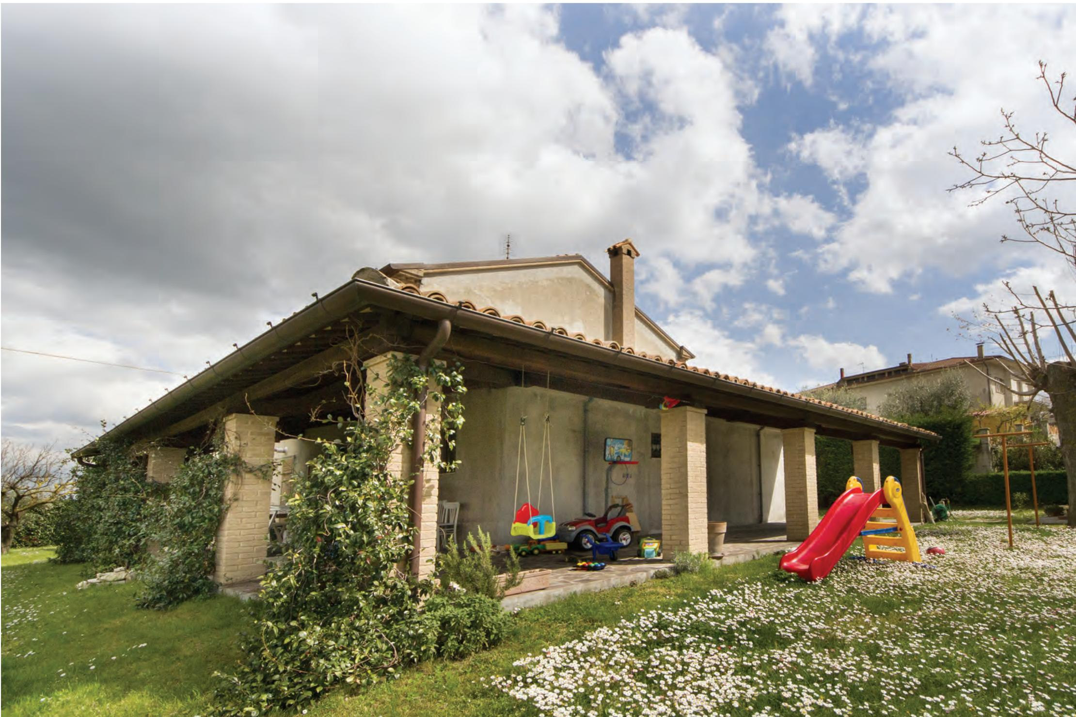
Porticato con colonne in mattoni anticati e copertura con travi di rovere uso fiume.
