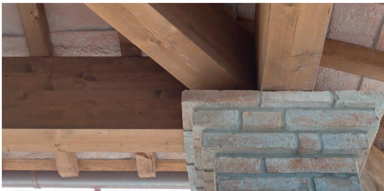
Particolare di appoggio trave diagonale su pilastro rivestito con mattone antico
