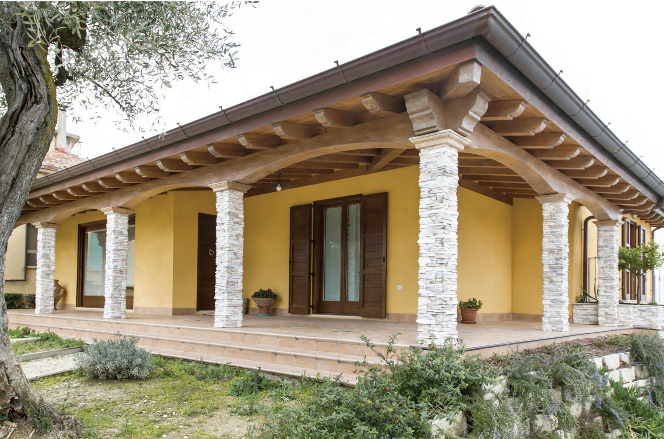
Casa in legno con pannelli X-LAM, copertura con travi in abete lamellare, sistema isolante a cappotto con pannelli di fibra di legno e finitura con intonachino Biocalce Silicato Puro - Kerakoll, rivestimento in pietra ricostruita Kerma Biopietra
